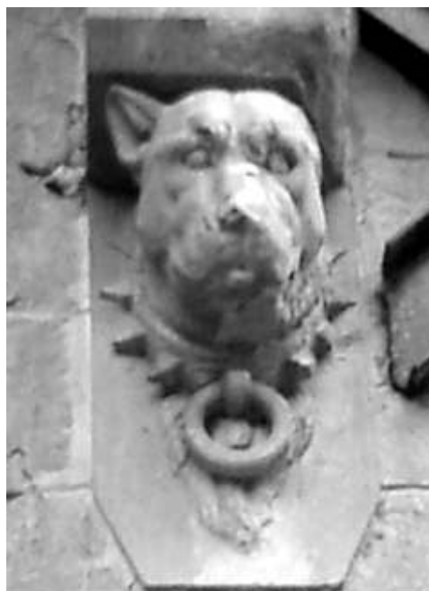
Alfred W. Strohl-Fern, particolare della testa di cane, danneggiata, che sorregge il lato destro del balcone
