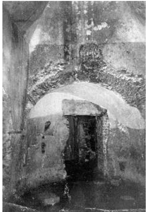
Il Ninfeo romano sottostante la portineria, in una fotografia del 1980
