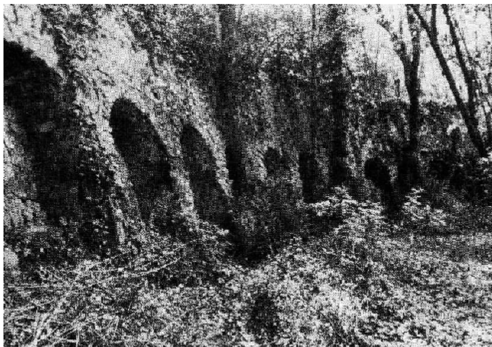
I contrafforti nella parte nord del parco, oggi non più visitabile
