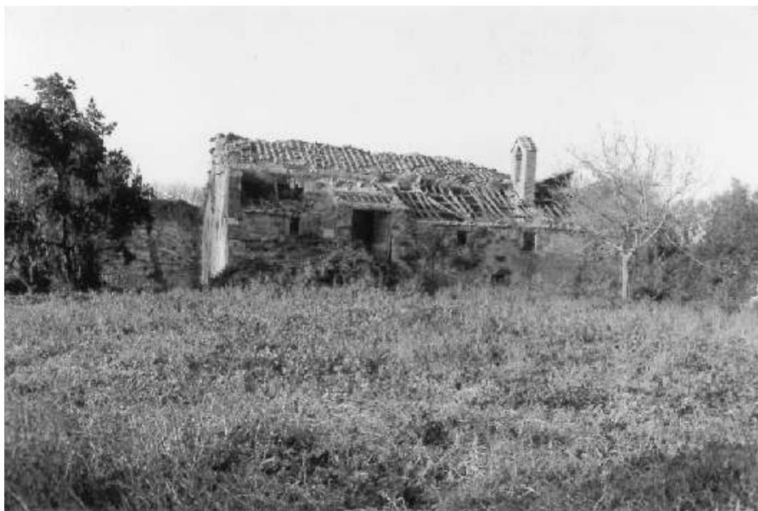
Lato sud (particolare), foto E. Perugi, 1993
