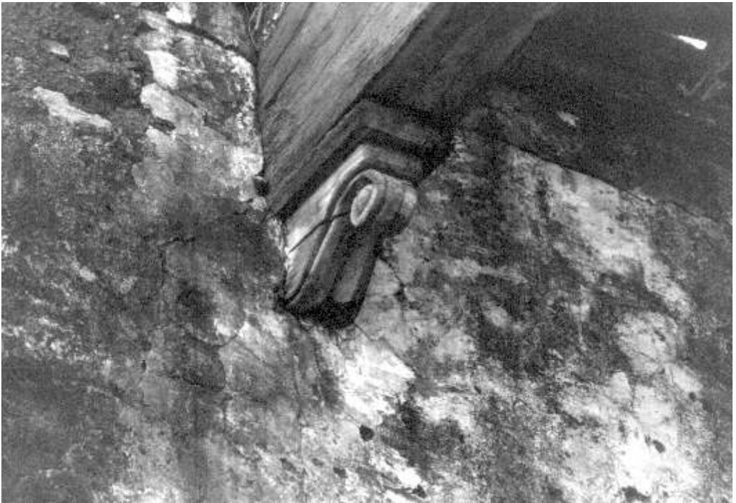
Mensole di sostegno alle capriate, foto E. Perugi, 1996
