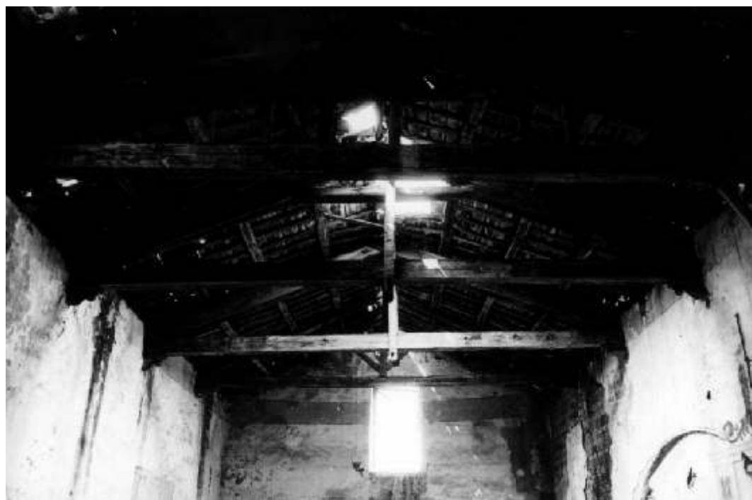
Il tetto della chiesa, foto F. Mascherucci, 1978
