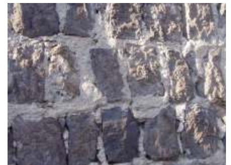
USM 3: muro Sud Est del Palazzo
