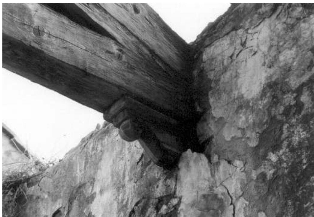
Mensole di sostegno alle capriate, foto E. Perugi, 1996
