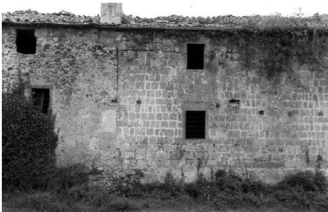
Lato nord, foto E. Perugi, 1993
